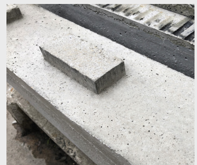
Halteklötzchen aus faserverstärkten Beton.
