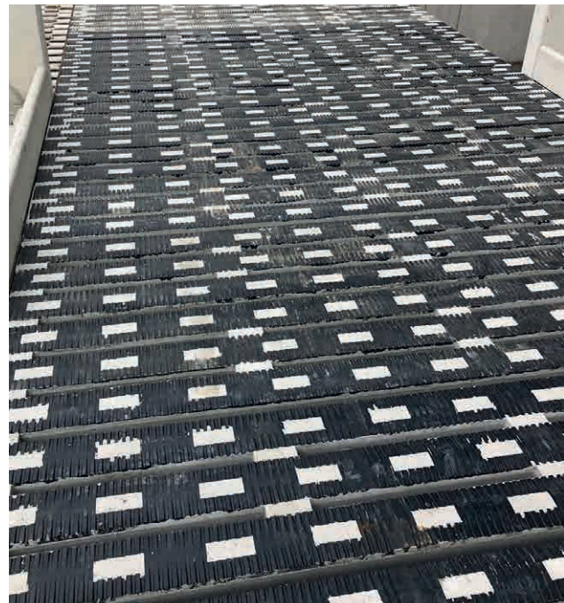
Halteklötzchen aus faserverstärkten Beton.
